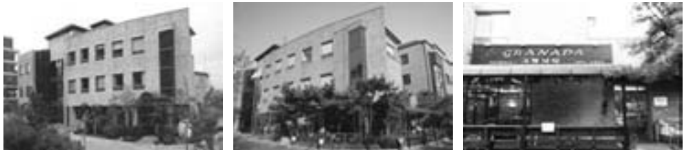
[그림 11] 그라나다카페 전경(복지관 1층 식당의 카페공사 전·후)
