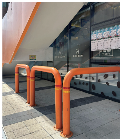
계단 하부 보행자 충돌 방지용 안전펜스 설치 사례 @배용호
