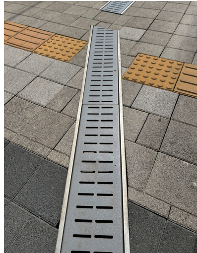
간격이 좁은 배수구 설치 사례 @배용호
