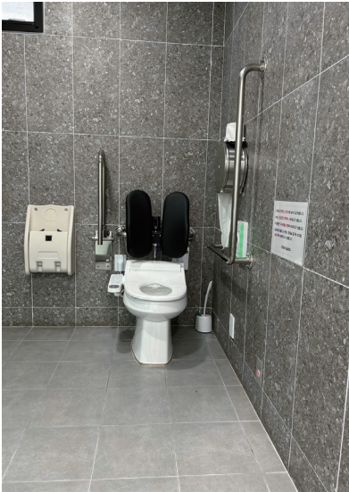
대변기 전면 및 측면 공간 확보 사례 @배용호
