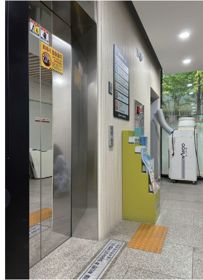
엘리베이터 버튼 전면의 점형블록 설치 @배용호
