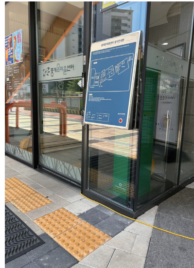
주출입문 옆 촉지도식안내판과 점형블록 설치 @배용호
